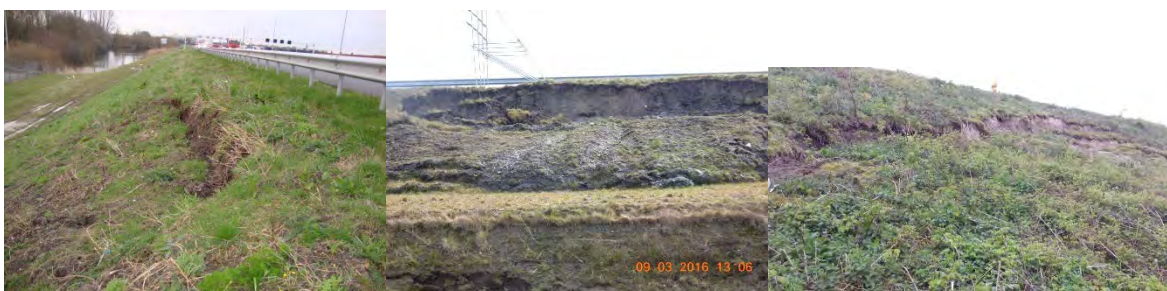
Foto: Afschuiving van talud.
