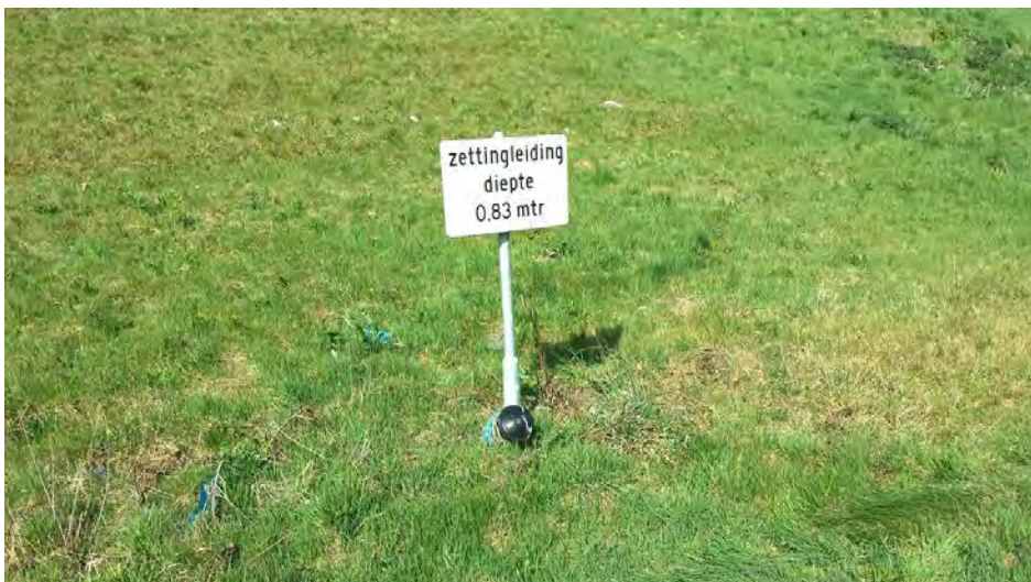
Foto: Duidelijk markering zettingsleiding.
