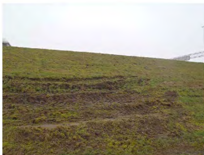
Foto: Maaischade aan afdeklaag.
