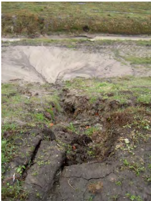
Foto: Erosie van afdeklaag.
