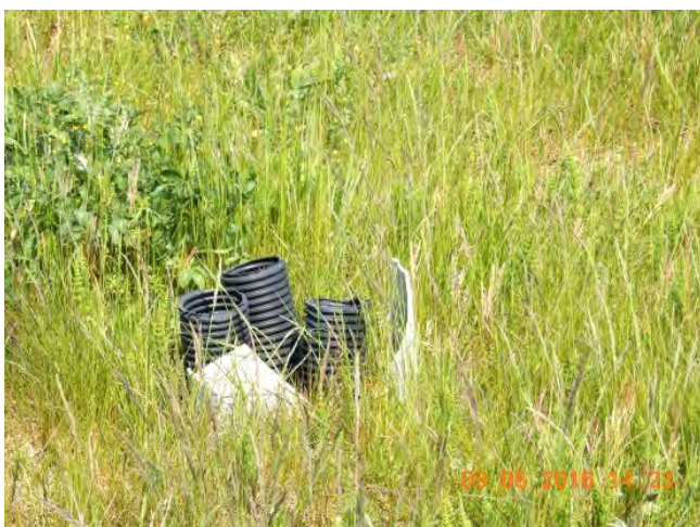
Foto: Mantel om drainageleidingen beschadigd.
