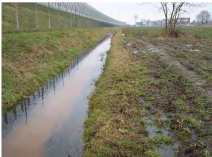
Foto: Problemen met drainage.
